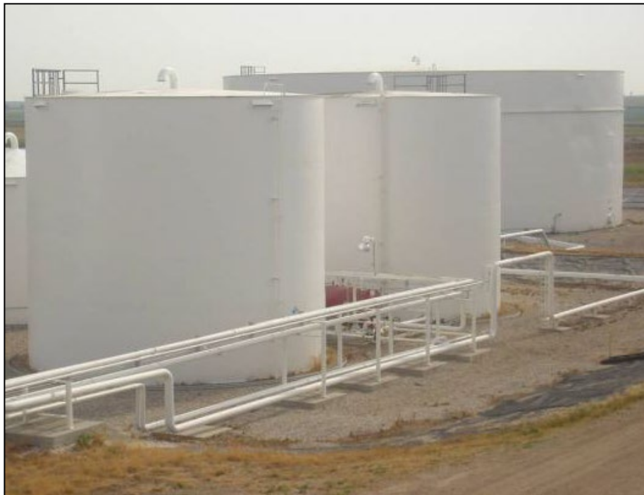
Figura 5.1: Tanque de almacenamiento con techo flotante interno
